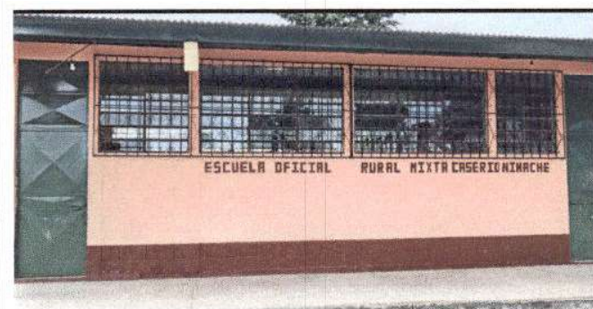
Foto 9: Finalización de fabricación de balcones de hierro en ventana, en modulo 3.
