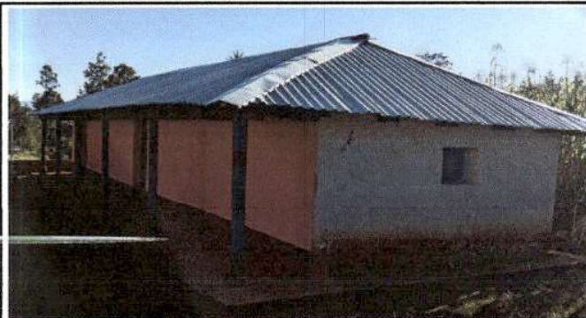
Foto 1: Finalización de sustitución de lámina por lámina troquelada aluzinc calibre 26, en módulo 1.
