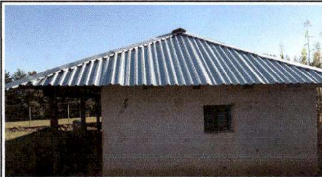
Foto 2: Finalización de sustitución de capotes, en módulo 1.
