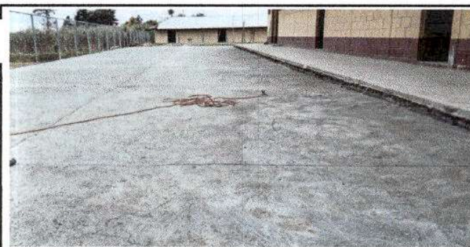
Foto 5: Finalización de reparación de planchas de concreto de patio, en módulo 2.
