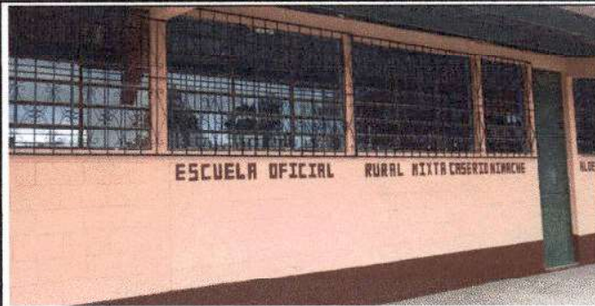
Foto 8: Finalización de fabricación de balcones de hierro en ventana, en modulo 3.
