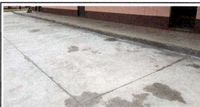
Foto 6: Finalización de reparación de planchas de concreto de patio, en módulo 2.
