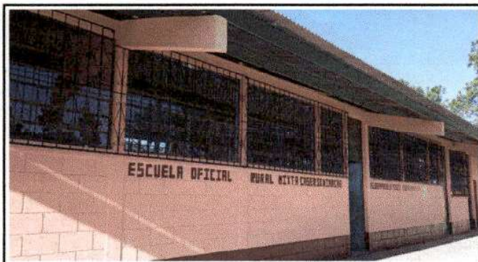
Foto 16: Finalización de pintura en exteriores e interiores, en modulo 5.
