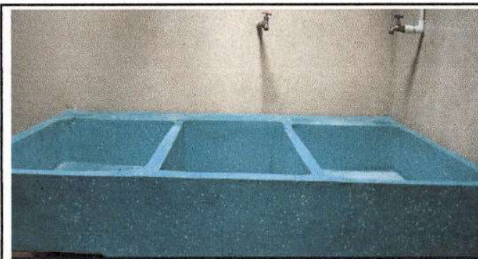
Foto 10: Finalización de instalacion de pila, en modulo 4.
