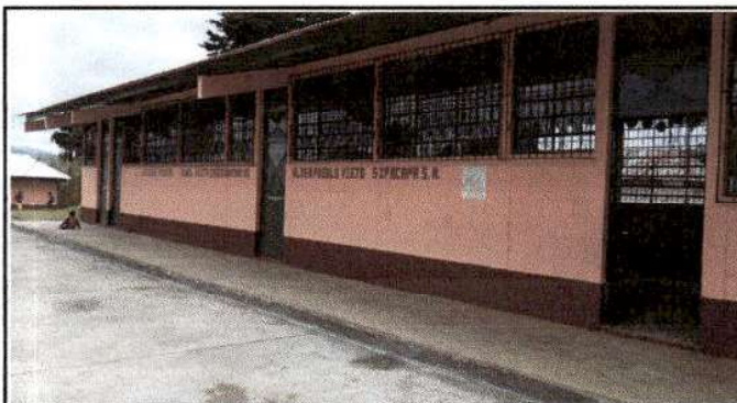
Foto 15: Finalización de pintura en exteriores e interiores, en modulo 5.
