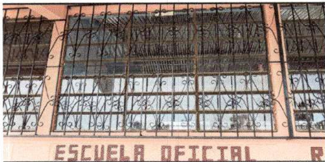
Foto 7: Finalización de fabricación de balcones de hierro en ventana, en modulo 3.
